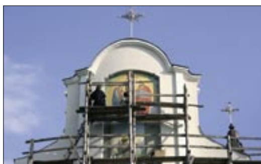
Wciąż trwają prace remontowe w iwienieckim kościele
