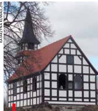
Nieużytkowany i niszczący zabytek zostanie rozebrany i przeniesiony do Warcina
