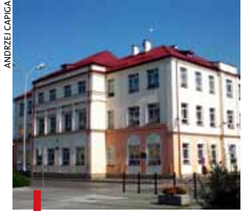
Budynek LO w Nisku przed liftingiem
