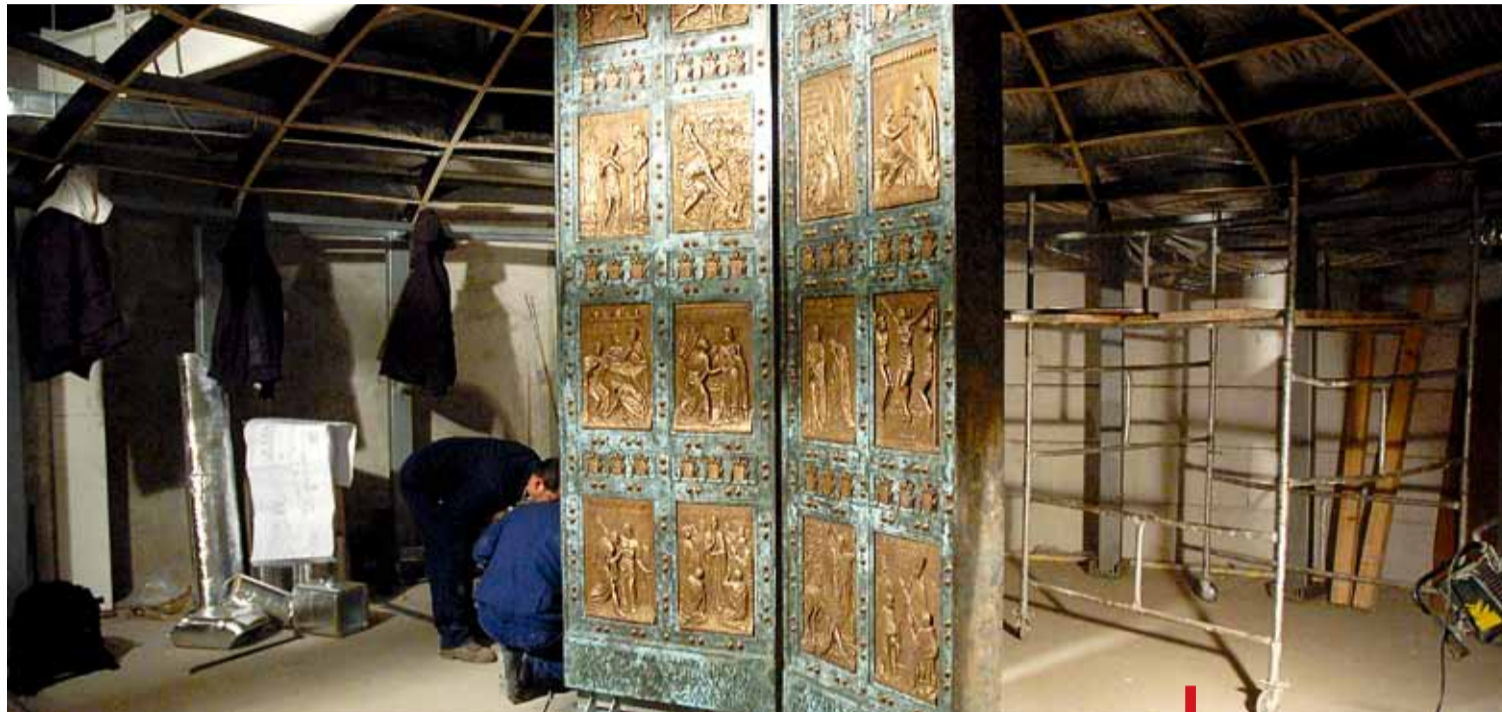
Montaż drzwi był skomplikowaną operacją
