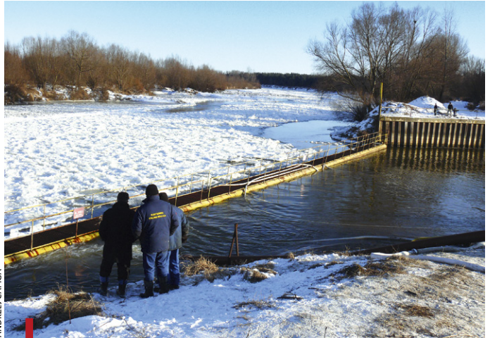
Zamrznięty San okazał się groźny dla elektrowni
