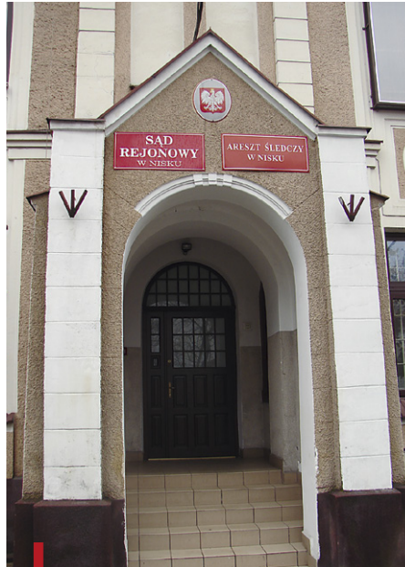
Siedziba placówki w Nisku w ostatnich latach przeszła gruntowny remont
