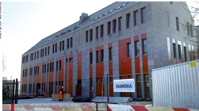
W przyszłym miesiącu ma zostać oddany do użytku nowy budynek sądu w Zabkowicach
