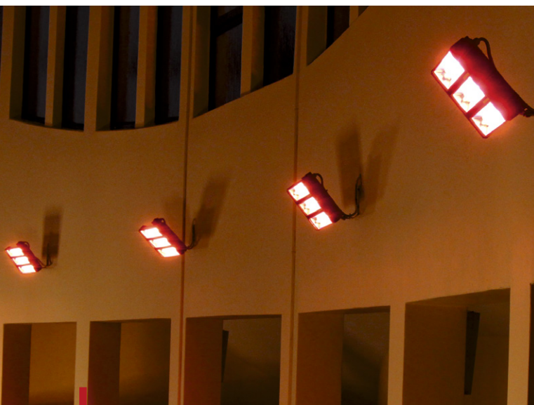
Promienniki ogrzewające w mroźne dni kościoł na wrocławskich Kuźnikach
