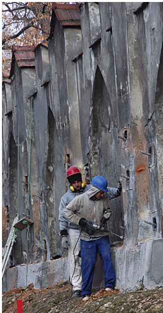
Przy ulicy Prymasa Stefana Wyszyńskiego spacery chodnikami będą już bezpieczne
