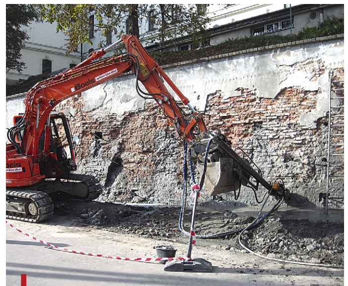
Tony betonu wstrzelone pod olbrzymim ciśnieniem scalą osłabioną strukturę muru
