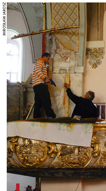
Konserwatorzy w trakcie przygotowań do zainstalowania żagla w łodzi-ambonie
