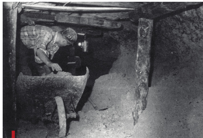
Praca w kopalni była ciężka i niebezpieczna
