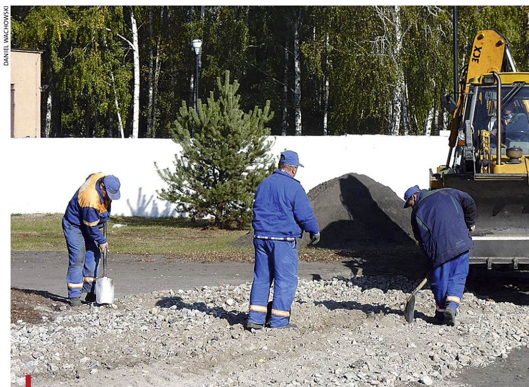
Pospolite ruszenie – drogi i autostrady w budowie. Na zdjęciu: utwardzanie dojazdu do sochaczewskiego osiedla
