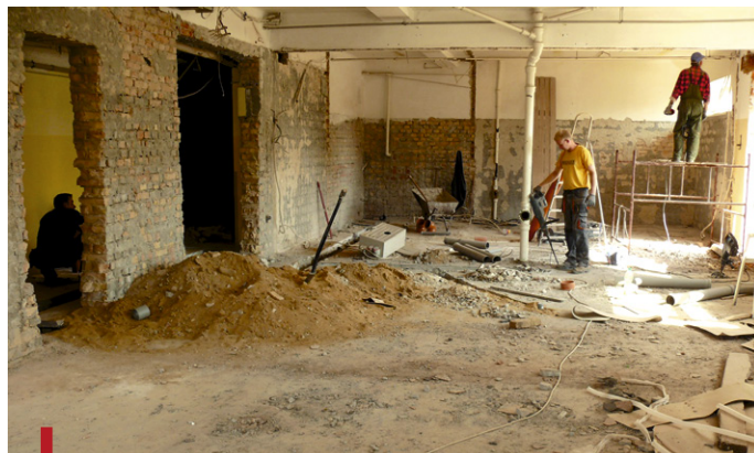
Prace budowlane ruszyły pełną parą
