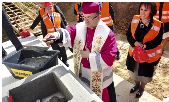
Kamień węgielny to metalowa tuba, do której włożono akt erekcyjny, dwa egzemplarze zielonogórskich dzienników, zdjęcie pracowników biblioteki UZ oraz ulotkę biblioteki
