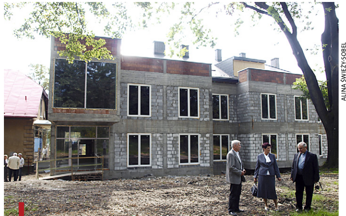
W budynku hospicjum rozpoczęto już prace wykończeniowe – mówią przedstawiciele SSH
