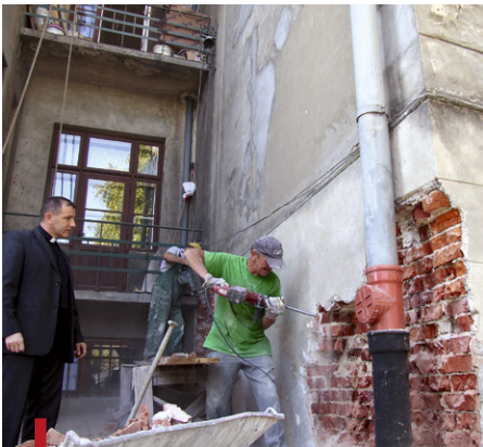
W tym miejscu powstaje druga klatka schodowa
