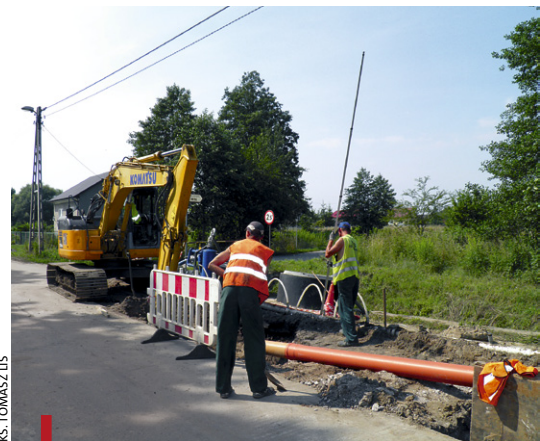
Realizacja projektu wodociągowego rozwiąże problemy mieszkańców
