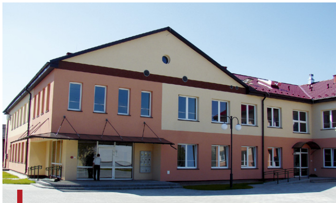
Budynek wielofunkcyjny wzniesiony tylko za samorządowe pieniądze
