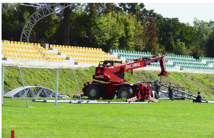
Modernizacja stadionu pochłonie około miliona złotych
