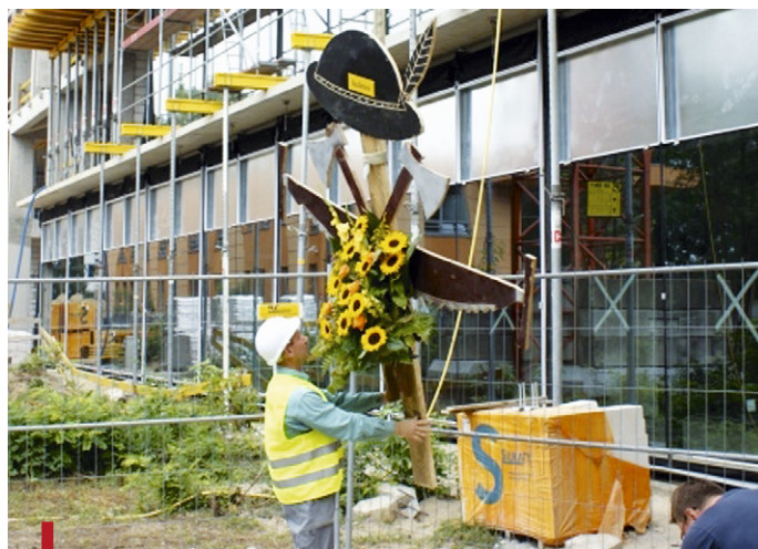
Na budynku Technoparku zawisła okazała wiecha
