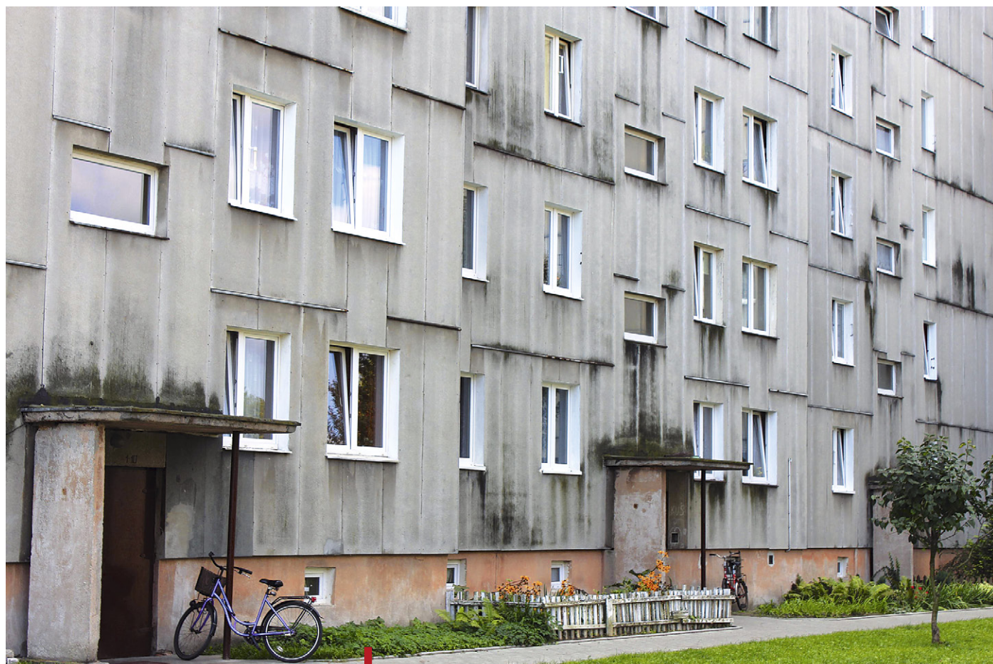
Na osiedlu „Ogrody” w sumie jest 6 bloków obitych azbestowymi płytami
