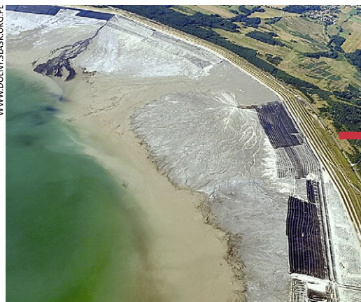
Zbiornik odpadów poflotacyjnych w Żelaznym Moście to największe tego typu przedsięwzięcie w Europie
