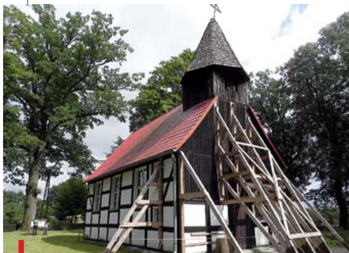
Zbudowany w 1803 r. kościół pw. Najświętszego Serca Pana Jezusa w Karnieszewicach to jeden z cenniejszych zabytków w gminie Sianów
