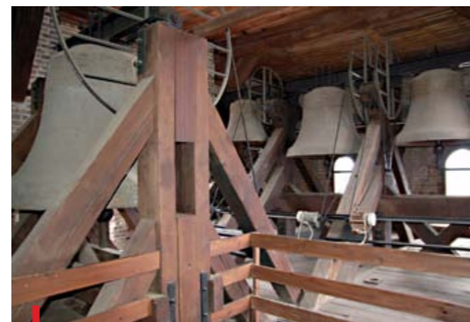
Średnica największego dzwonu wynosi 194 cm, a trzech mniejszych: 167, 146 i 120 cm. Łączna waga czterech dzwonów to ok. 7,5 tony
