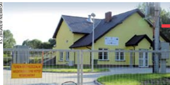
Kompleks budynków i urządzeń oczyszczalni znajduje się w lesie za wioską
