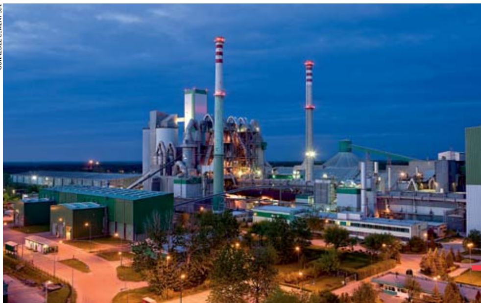
GÓRAŹDZE CEMENT S.A.
