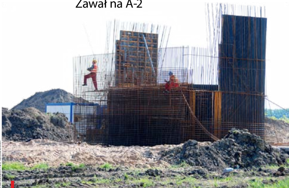
ŁYSZKOWICE. Autostrada A-2 od Strykowa do Konotopy ma być gotowa w maju 2012 r.
