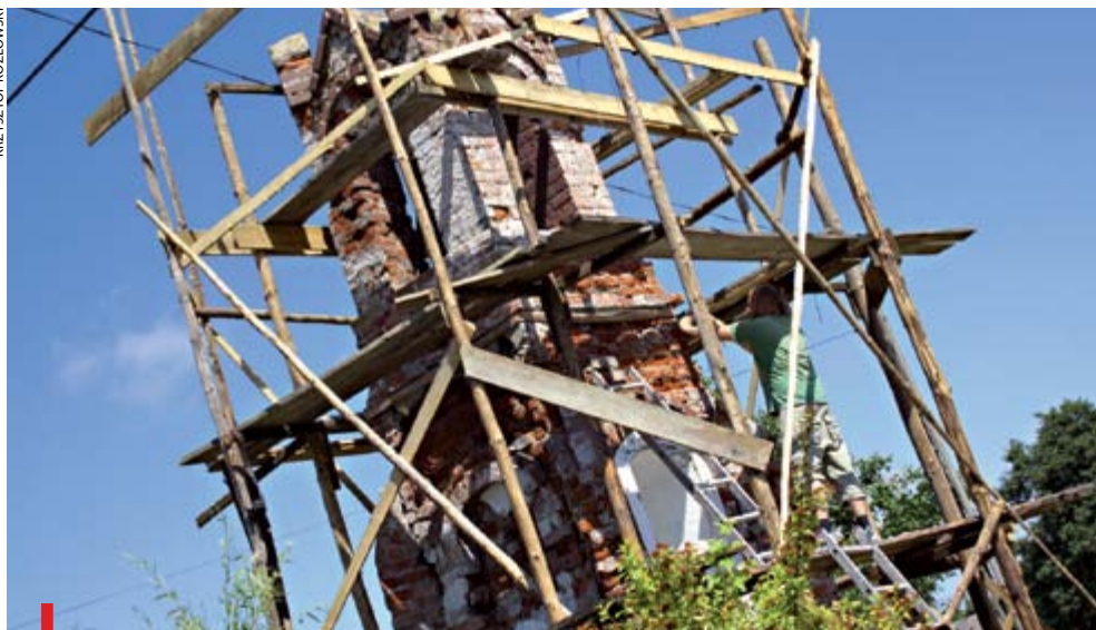
PUPKI, 8 LIPCA 2011 R. Jak mówią miejscowi, kolizje samochodowe z „udziałem” kapliczki nie są zdarzeniem rzadkim. Zapewne dlatego odsłonięta cegła jest spękana i rozkruszona
