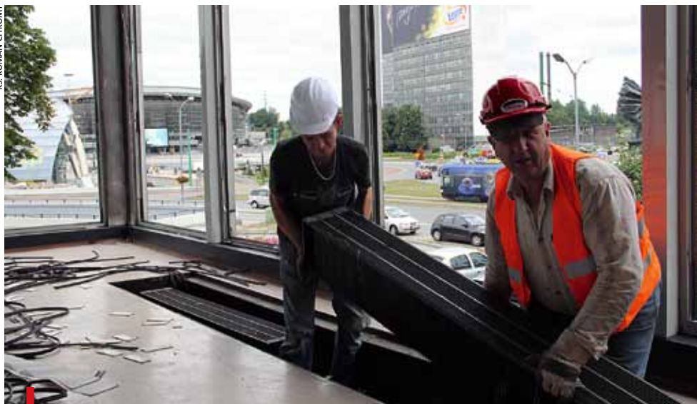
KATOWICE, 28. 06. 2011 Arkadiusz Warzecha (po lewej) i Władysław Król z Przedsiębiorstwa Budowlanego HPM podczas prac rozbiórkowych w Pałacu Ślubów
