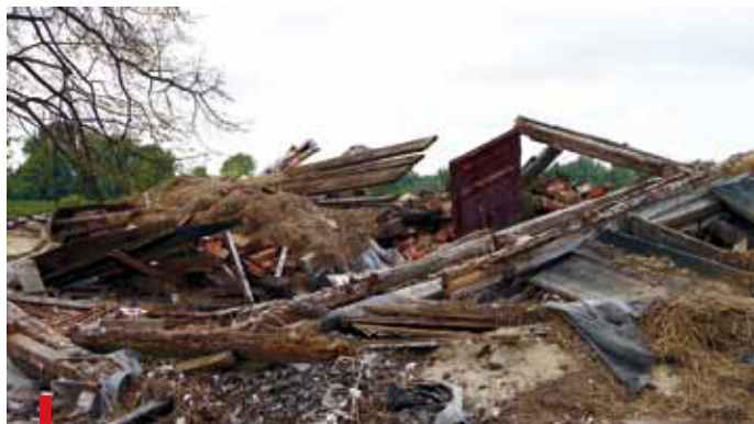
Nie udało się odbudować niektórych budynków mieszkalnych w Koćmierzowie
